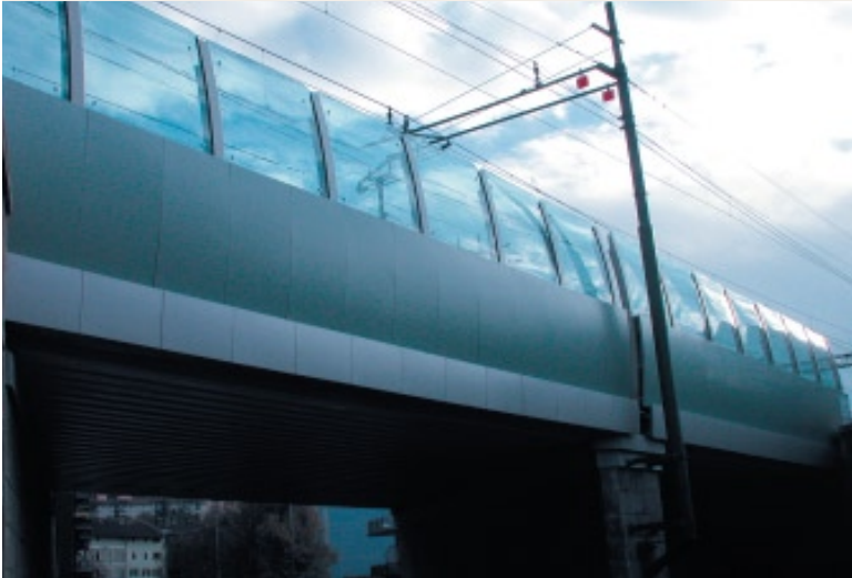
Шумозащитная стена Ponte Roma, Bolzano
