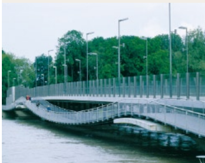
Шумозащитная стена Мост через Дунай в Ингольштадте
