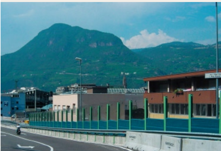
Шумозащитная стена Bolzano
