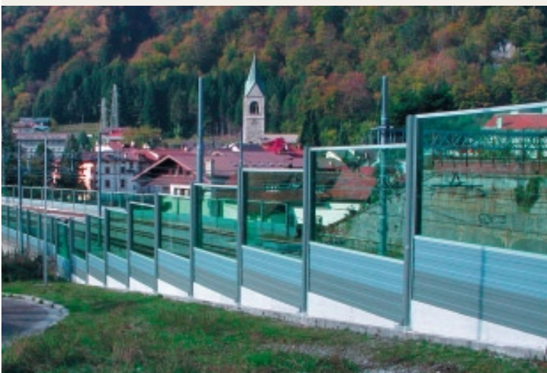
Шумозащитная стена Pontebba, Udine
