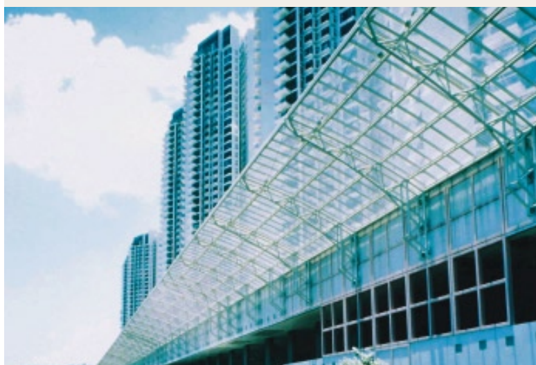
Шумозащитная стена Ho Lung Tao, Гонконг
