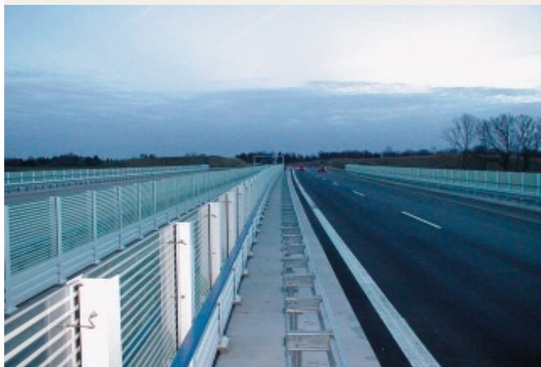
Шумозащитная стена Пересечение Траве, Любек
