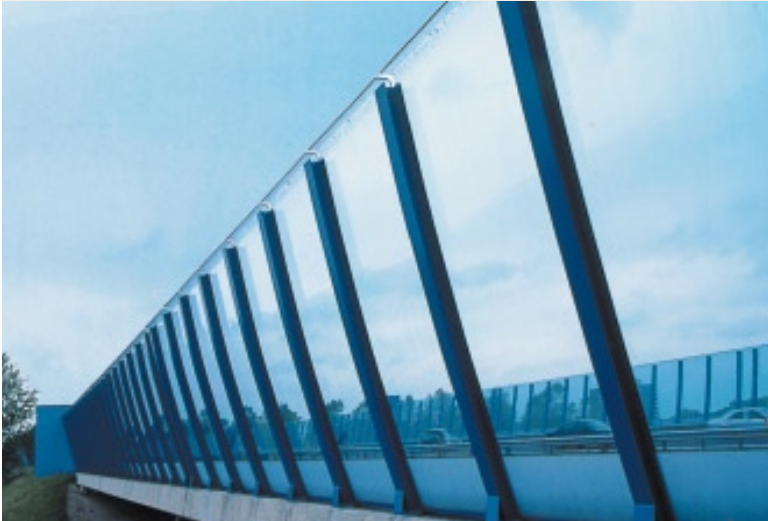
Шумозащитная стена Вельпербрек
