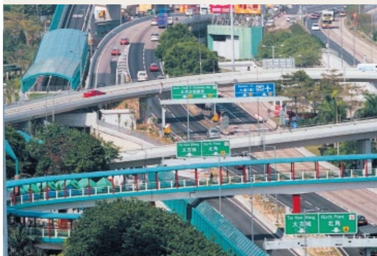
Шумозащитные стены, шумозащитный туннель Eastern Corridor, Гонконг
