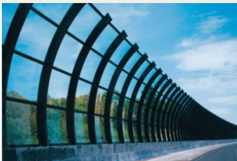
Шумозащитная стена M5, Melburne
